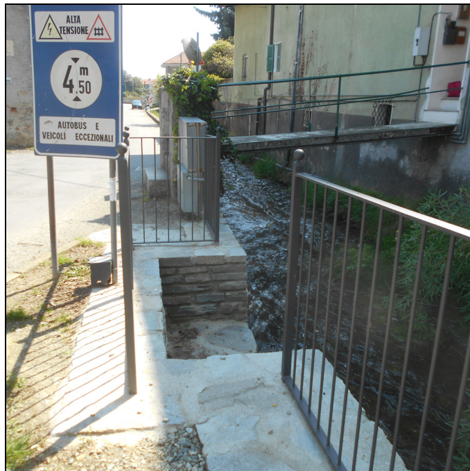
Fotografia n. 2: punto di posizionamento cancelletto.
