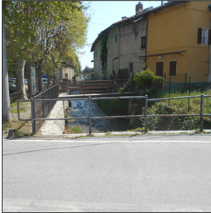
Fotografia n. 1: tratto di rifacimento del parapetto sul ponte visto da monte.
