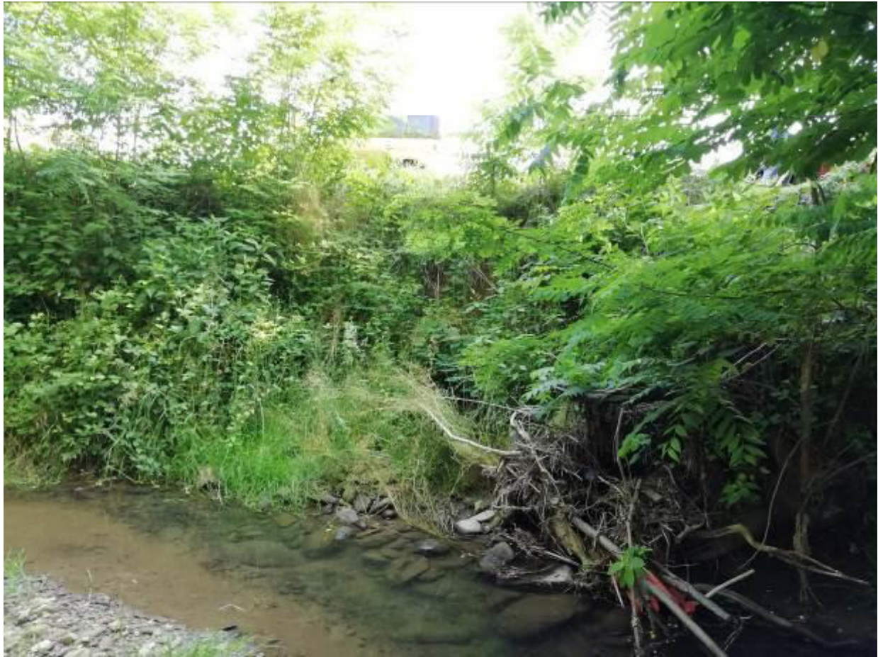
Vista del tratto di scarpata sinistra orografica del Torrente Chiamogna oggetto di sistemazione con realizzazione di un tratto di scogliera in massi di cava posati a secco
