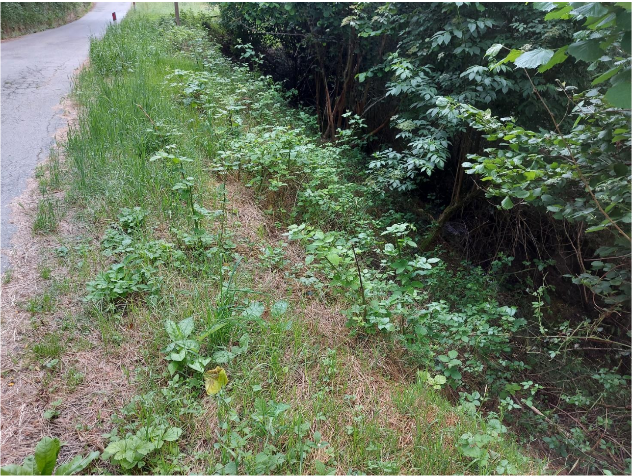
Foto 3. Vista della scarpata a valle della gabbionata esistente.
