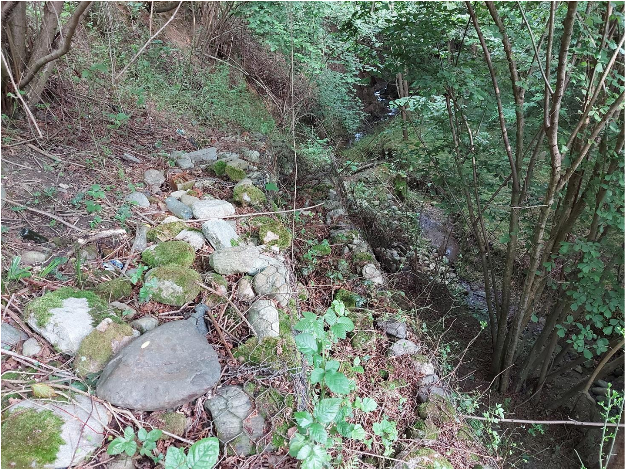
Foto 1. Vista della gabbionata esistente.
