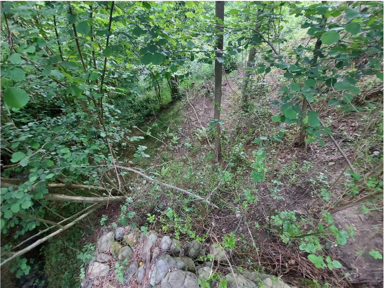
Foto 2. Vista della scarpata a monte della gabbionata esistente.
