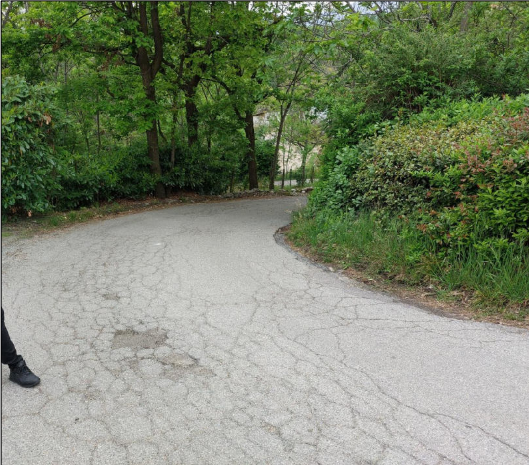
Nota esplicativa: Foto 3. Tratto di Strada Santa Caterina nel quale sarà realizzata la canaletta, vista verso valle (intervento 1).
