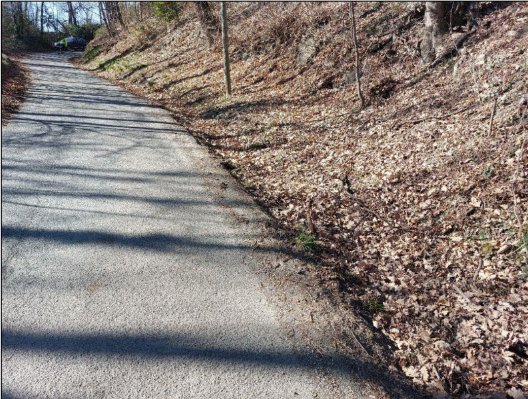
Nota esplicativa: Foto 2. Tratto in cui sarà realizzato l'attraversamento stradale, con annesso pozzettone e soglia in massi a secco (Strada Santa Caterina, intervento 2).
