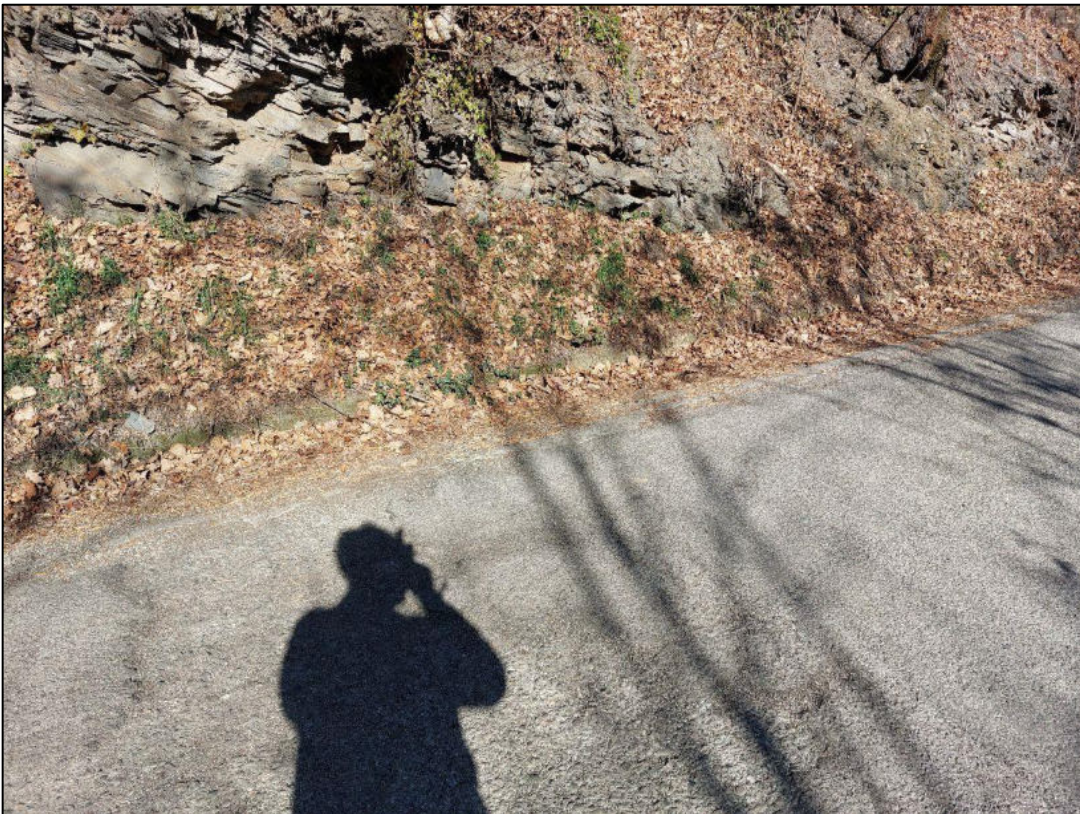
Nota esplicativa: Foto 3. Tratto di strada con cunetta già esistente in cls (Strada Santa Caterina, intervento 2).
