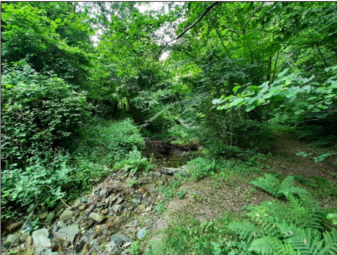
Nota esplicativa: Foto 4. Briglia esistente da sistemare, vista da ovest (Strada Canavero).
