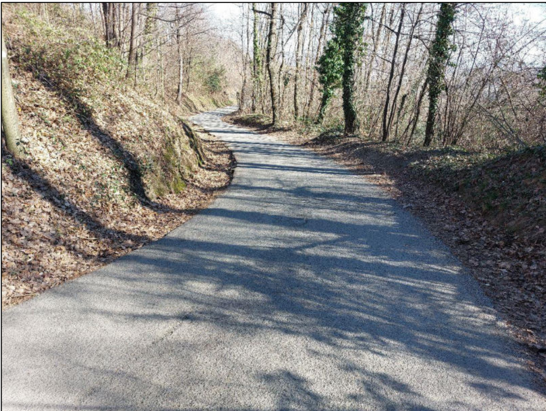
Nota esplicativa: Foto 1. Tratto iniziale della Strada Santa Caterina nel quale sarà realizzata la cunetta (intervento 2).
