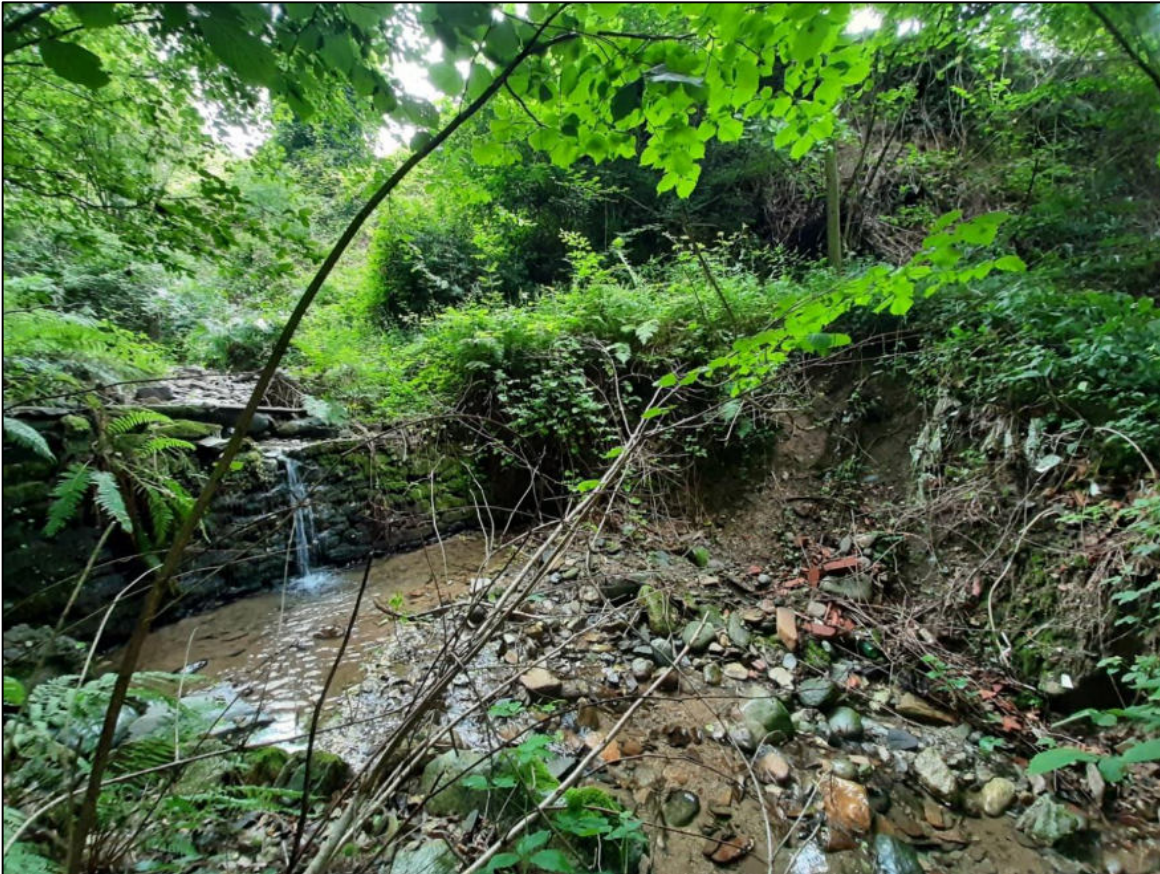
Nota esplicativa: Foto 5. Briglia esistente da sistemare, vista da sud (Strada Canavero).
