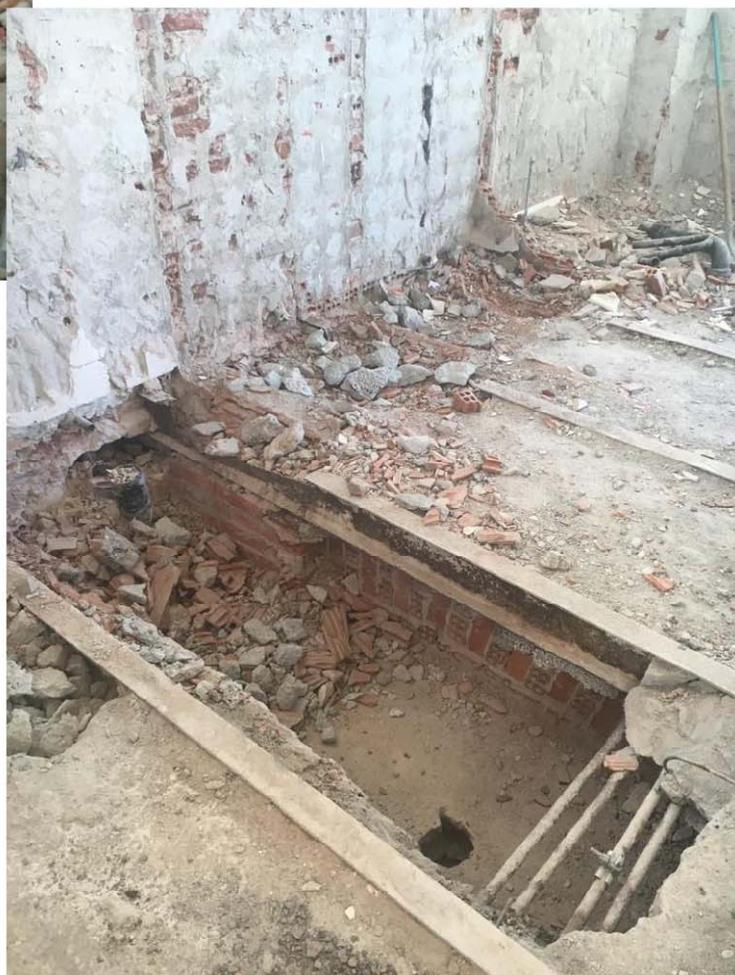
Blocco bagni al piano primo - ritrovamento strato di macerie sottopavimento con profilati metallici manomessi
