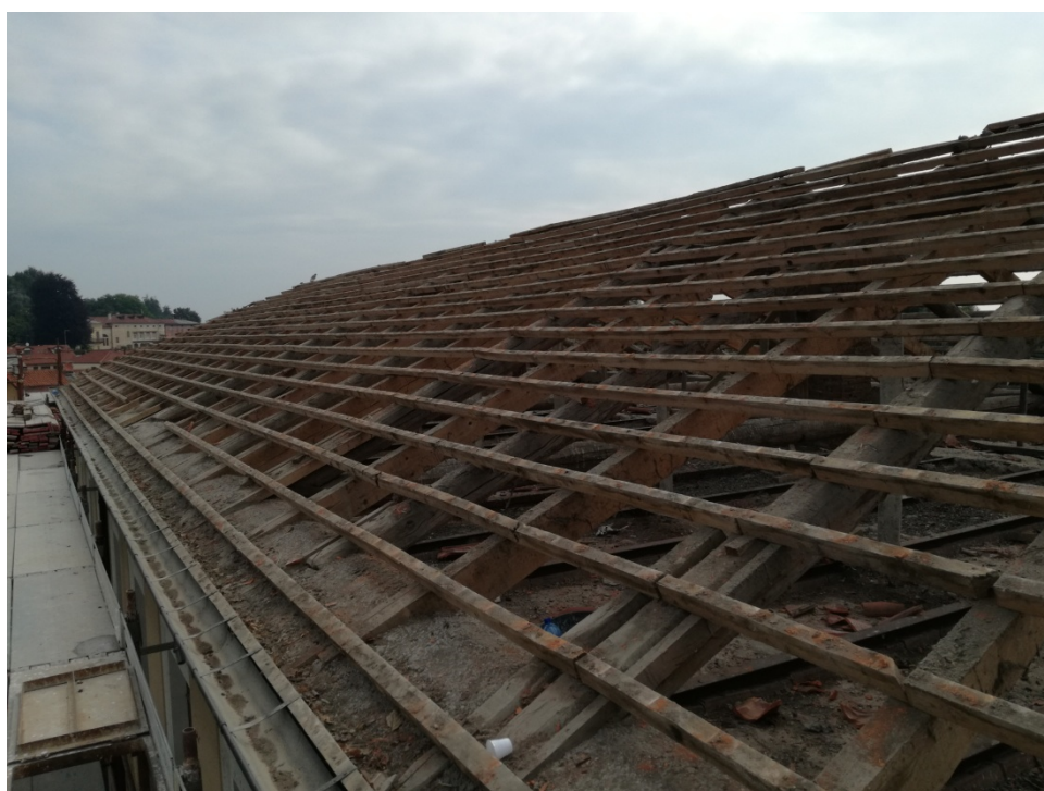
Immagine n. 2 - cordolo perimetrale esistente alla quota di imposta della copertura
