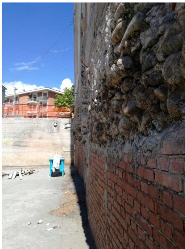
Immagine n. 1 - sottomurazione edificio principale emersa nel corso dei lavori
