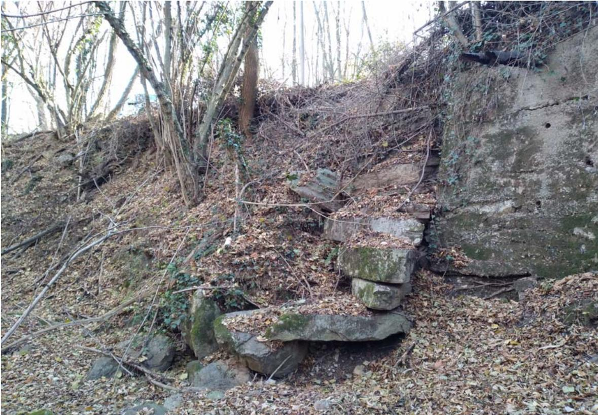
Dissesto visto da valle con muro in cls da demolire e scogliera esistente crollata
