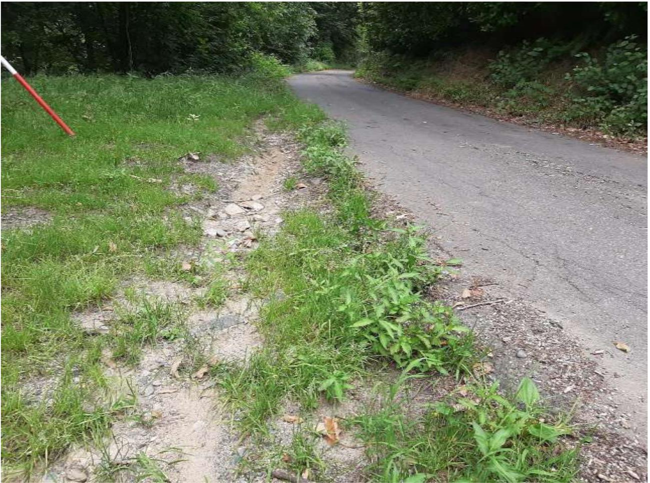
*Vista verso monte di strada Canavero nella zona più a monte di intervento. In fondo si prevede il nuovo canale trasversale in c.a. con griglione in ghisa sferoidale D400 ed il primo scarico verso il sottostante corso d'acqua mediante canaletta metalliche in mezzi tubi DN 600 mm. Sulla sinistra della foto del ciglio stradale si prevede invece la nuova cunetta laterale in c.a.*
