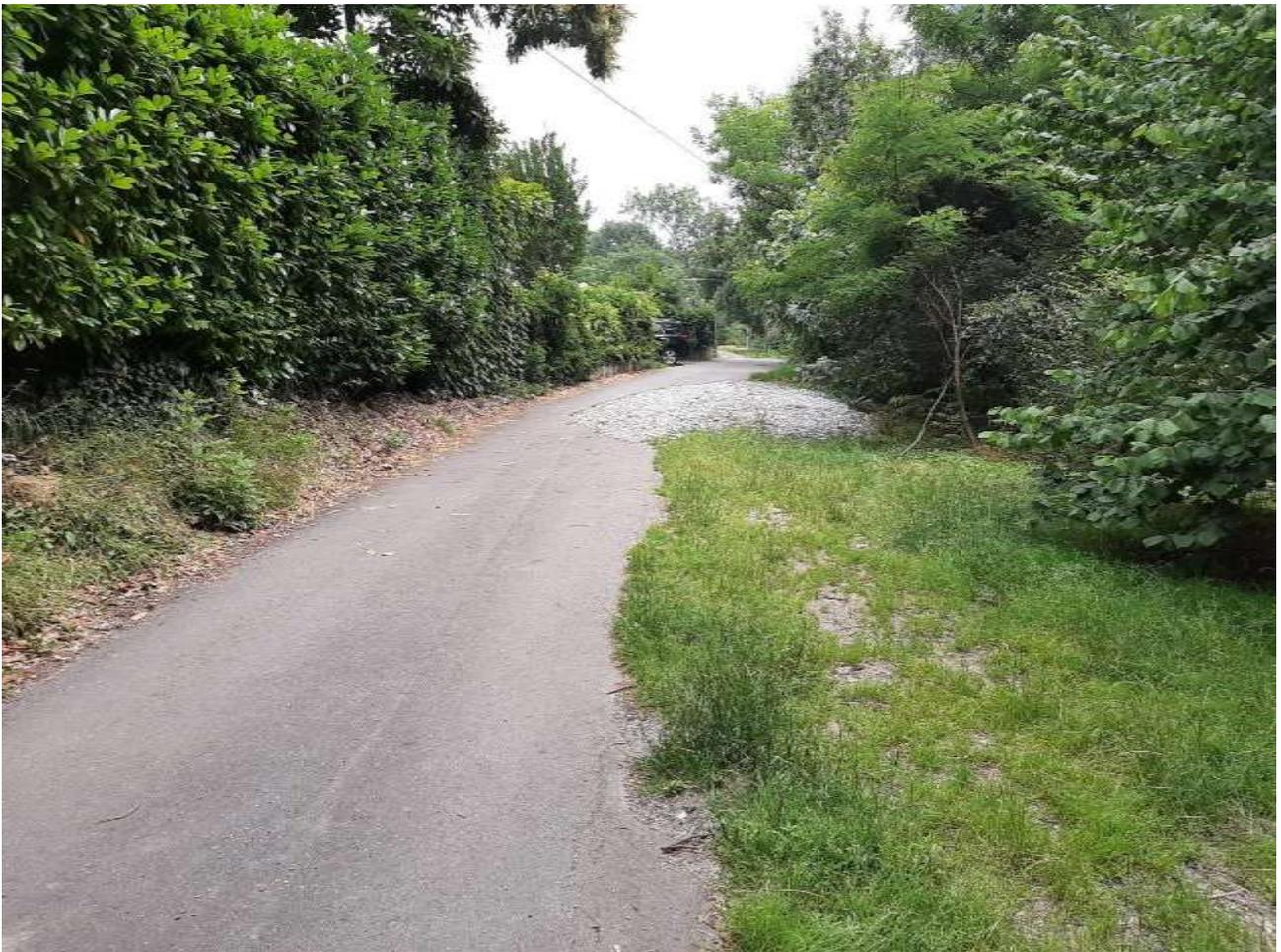
*Vista verso valle di strada Canavero nella zona più a monte di intervento. Qui sulla destra del ciglio stradale si prevede la nuova cunetta laterale in c.a. e, al fondo della medesima, il secondo scarico verso il sottostante corso d'acqua mediante canaletta metalliche in mezzi tubi DN 600 mm.*
