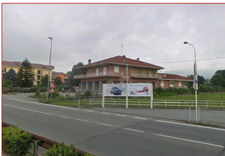
Vista della Localizzazione stradale Circonvallazione
