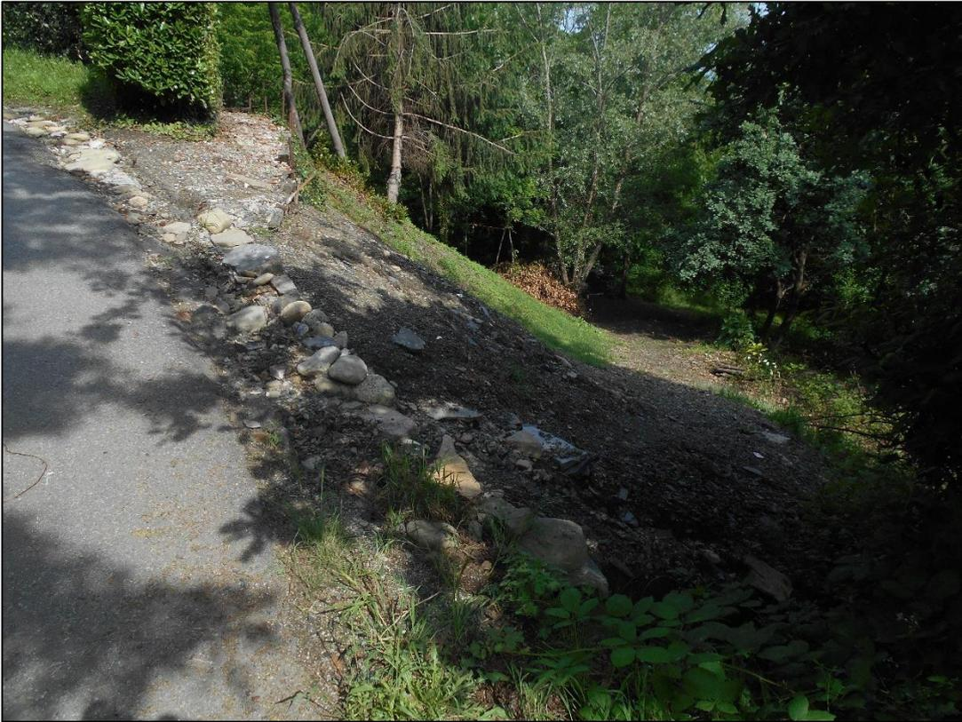
Nota esplicativa: Foto 2. vista della scarpata di valle di strada Cesani Sardegna con erosioni dovute al ruscellamento delle acque meteoriche, zona oggetto di nuova opera di sostegno e di regimazione delle acque.
