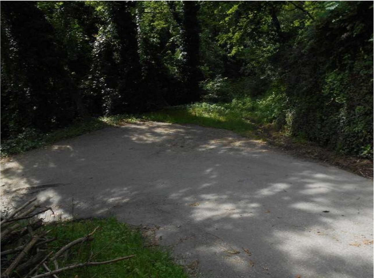
*Figura 4 – vista del tornante di strada Cesani Sardegna, tratto terminale della cunetta alla francese di monte esistente da pulire e ripristinare con idonee malte, e zona del nuovo attraversamento secondario di monte per smaltimento delle acque verso l'impiuvio presente a valle.*
