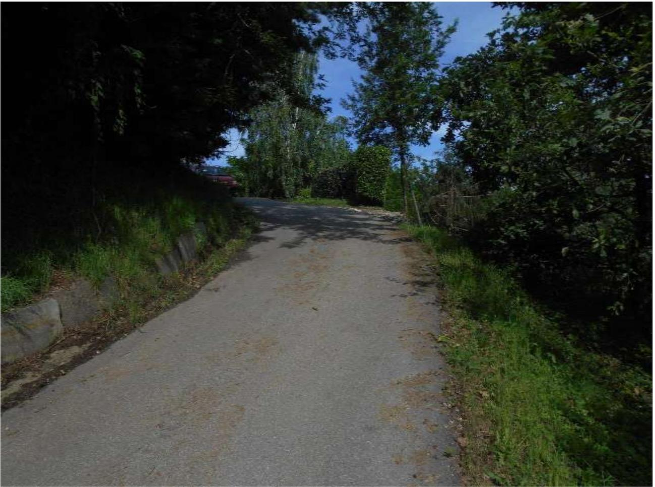
*Figura 3 – vista di strada Cesani Sardegna poco a valle della zona di realizzazione della nuova scogliera. A sinistra invece si può notare la cunetta alla francese di monte da pulire e ripristinare con idonee malte.*
