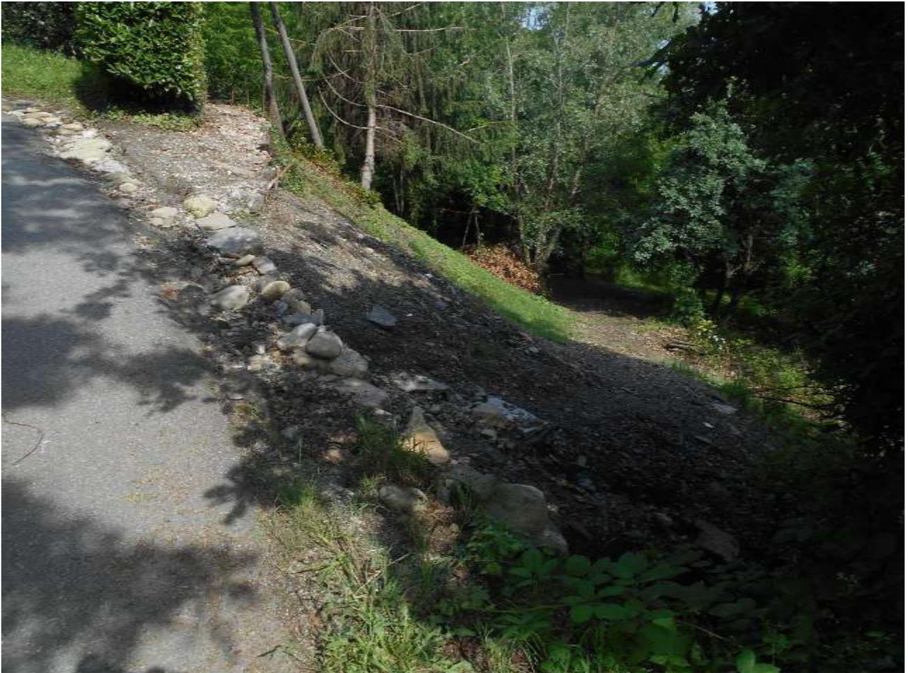
*Figura 2 – vista della scarpata di valle di strada Cesani Sardegna con erosioni dovute al ruscellamento delle acque meteoriche, zona oggetto di nuova opera di sostegno e di regimazione delle acque.*
