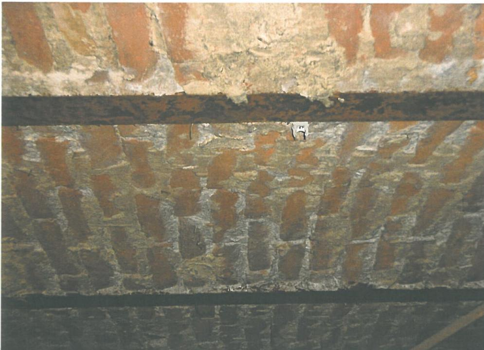
*Vista di uno dei solai in putrelle e voltine a copertura dell'interrato.*
