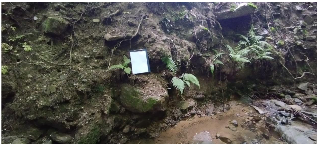
Ripresa fotografica 2 (13/05/24): dettaglio della scarpata che definisce la sponda sinistra del rio lungo il quale è previsto l'intervento di sistemazione in esame; la superficie esposta permette di valutare le caratteristiche dei depositi alluvionali in affioramento.
