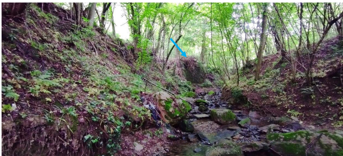
Ripresa fotografica 1 (13/05/24): tratto d'alveo oggetto di intervento (la freccia blu indica il muro in demolizione) modellato entro i depositi alluvionali riferibili al bacino del Torrente Chiamogna.
