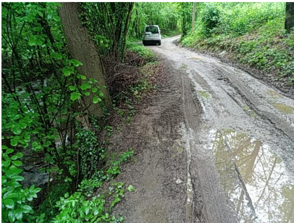
Foto 4 – Zona di intervento- vista da monte
