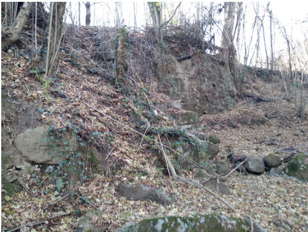
Foto 3 – scarpata da ripristinare
