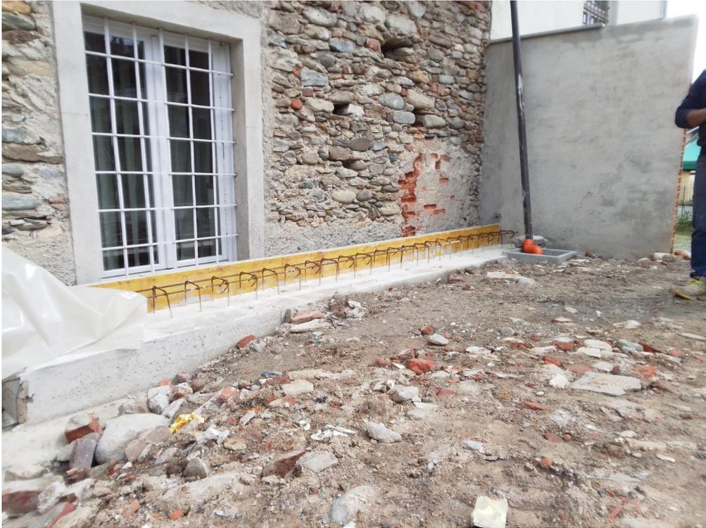
Edificio “Centro Anziani” – prospetto sud dell’edificio – muretto di protezione a finestre in fase di realizzazione
