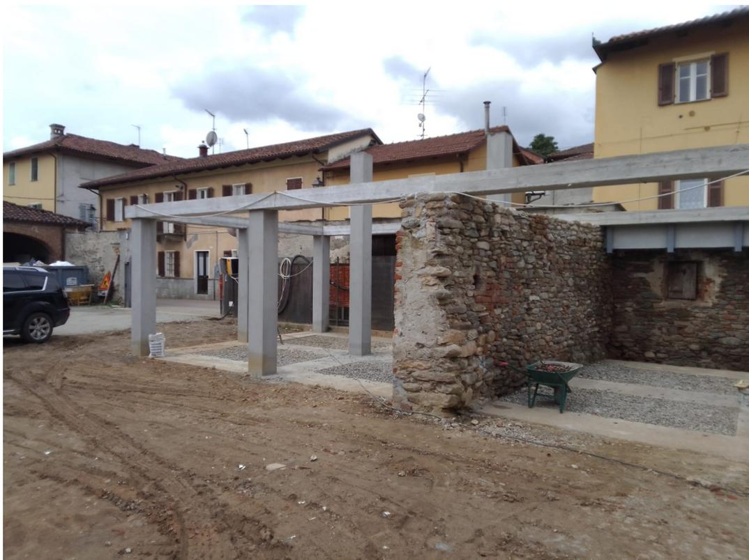
Edificio “Collabente” – prospetto est, modifica a muratura portante esistente
