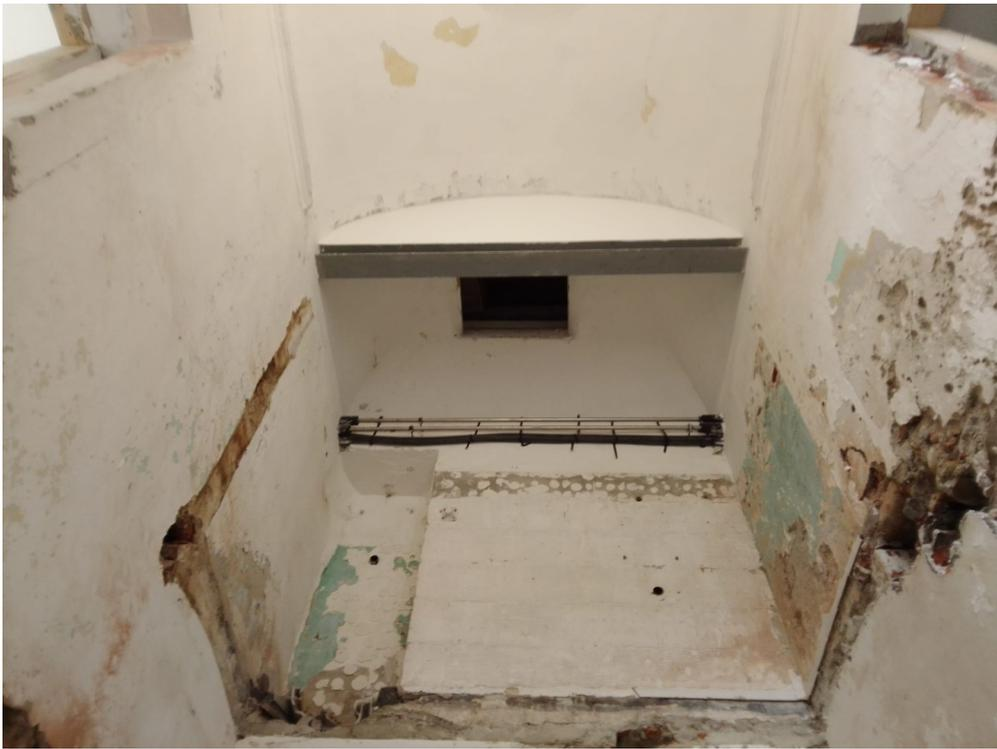
Sede associazioni – vano scala – posa di nuova trave in acciaio a sostegno della lunetta in muratura
