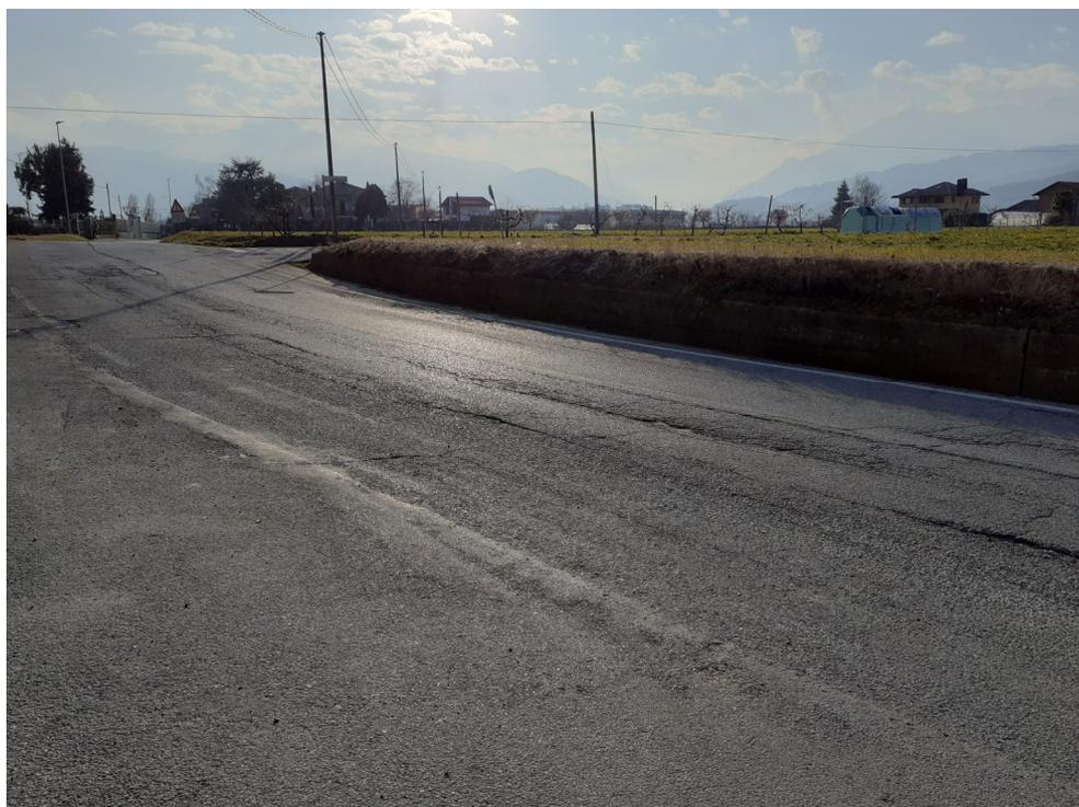
**Figura 5.5** Vista della Strada Provinciale 158 presso l'incrocio di Via Tirabrase in parziale trincea rispetto il piano terreno dei campi limitrofi.
