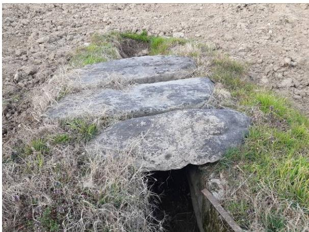
Figura 48 – Lastroni copertura canale
