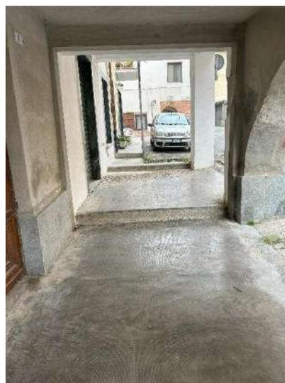
Fig. 4.2.1 – Esempi di raccordi mancanti che impediscono il passaggio
