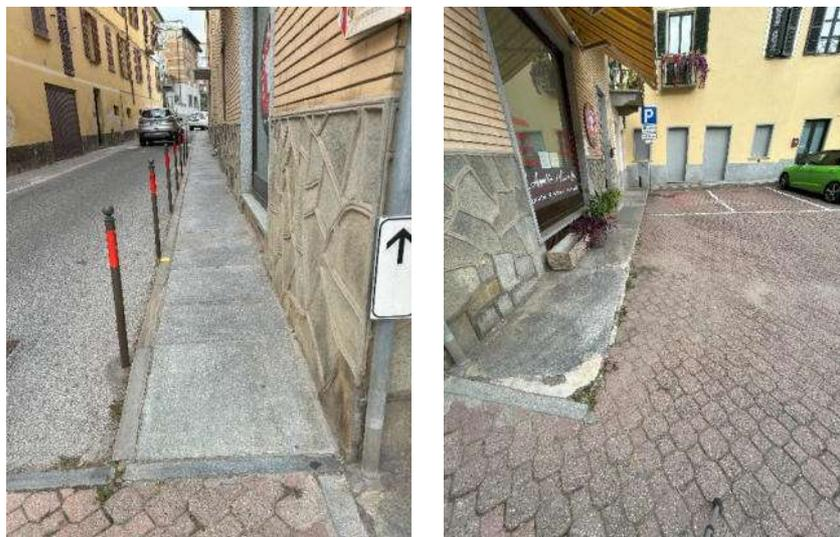
Fig. 4.2.2 – Esempi di marciapiedi privi di spazio di inversione e presenza ostacoli che impediscono il passaggio
