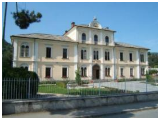
Torre Pellice, Casa Valdese
