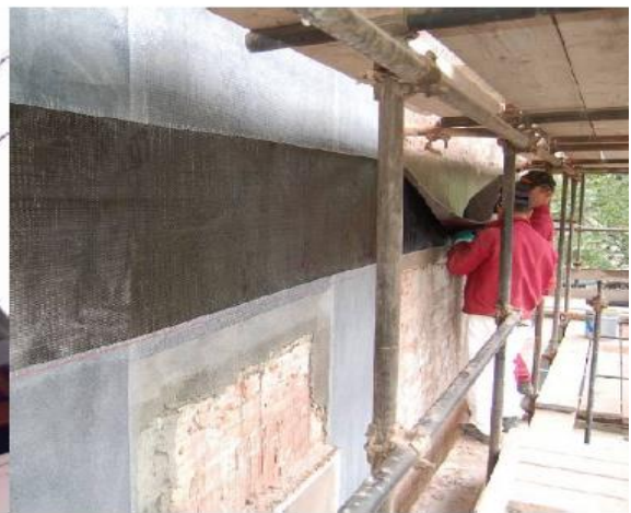
Esempi di cerchiatura esterna per tirantatura a cavo
