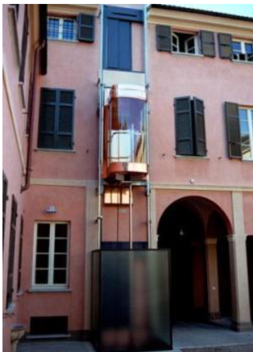
Inserimento di ascensore esterno in edificio storico.
