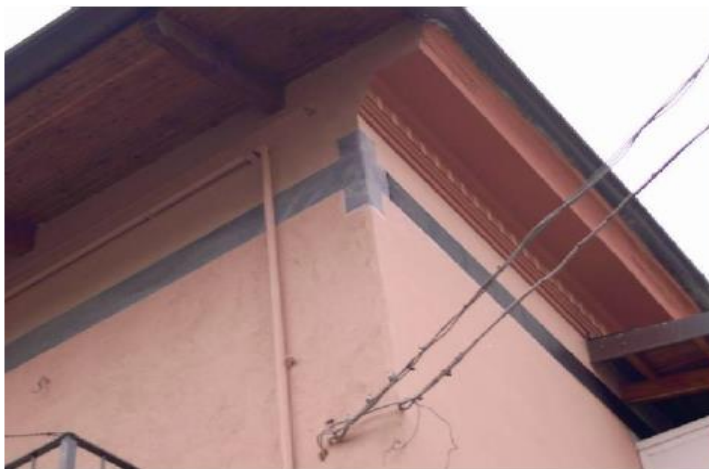
Esempio di cerchiatura esterna con fibra di carbonio
