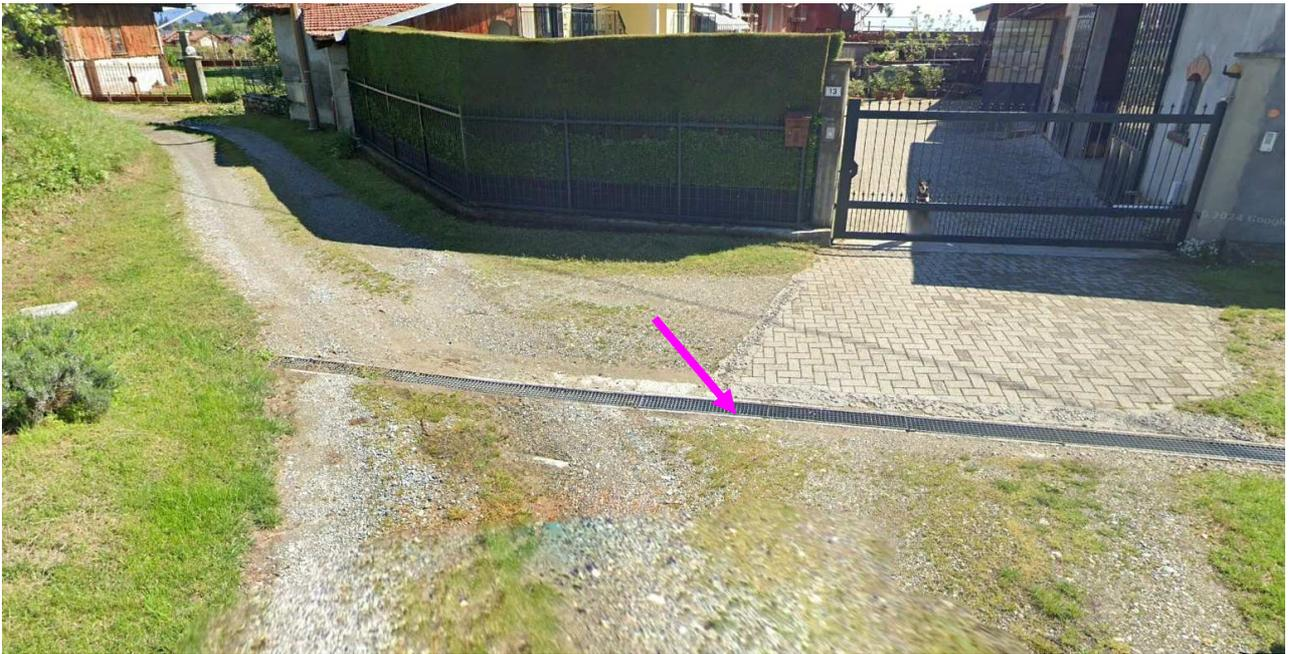
Canaletta da sostituire
